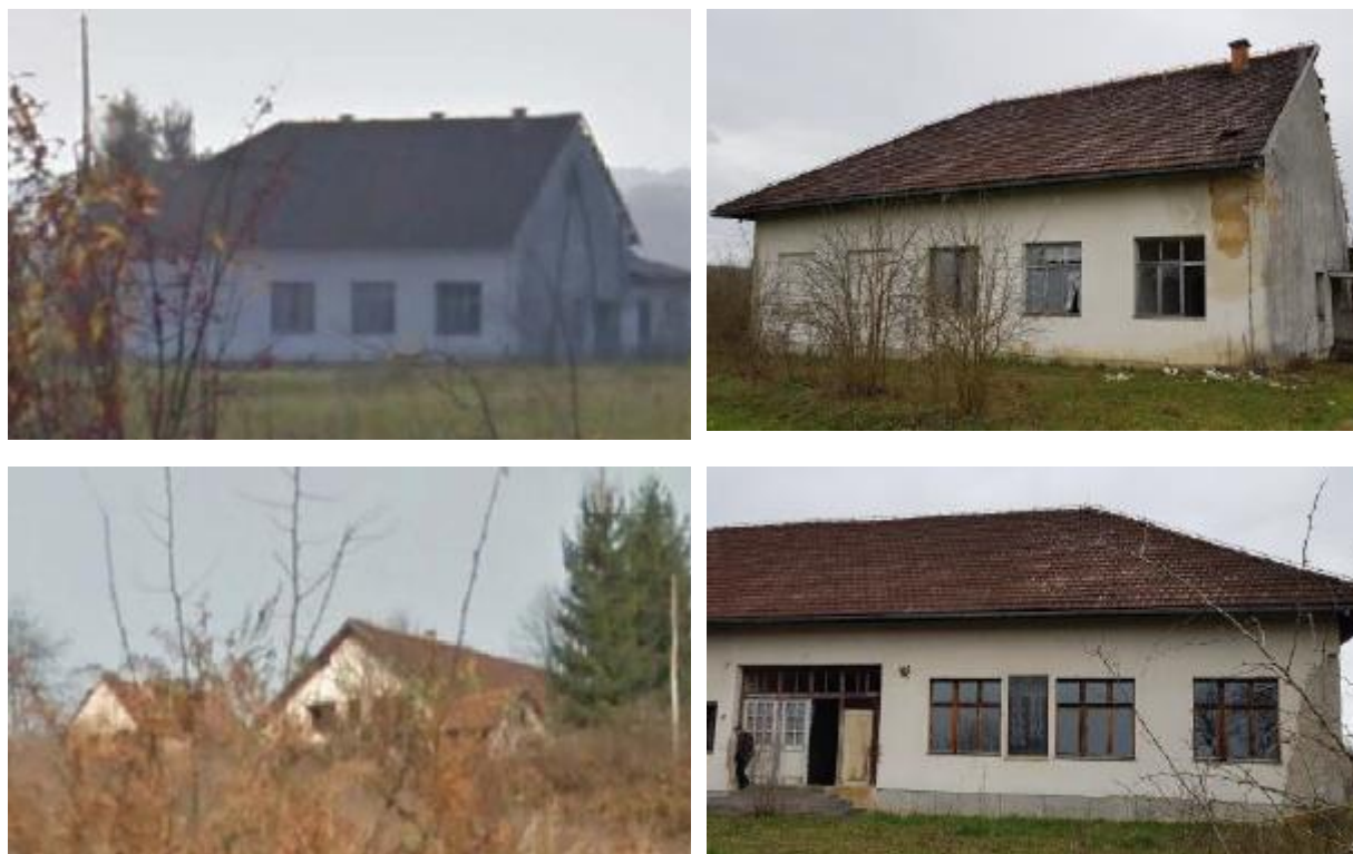
Slika 2.1 Postojeće stanje objekata na lokaciji planirane punionice (Izvor: Idejni projekt)
